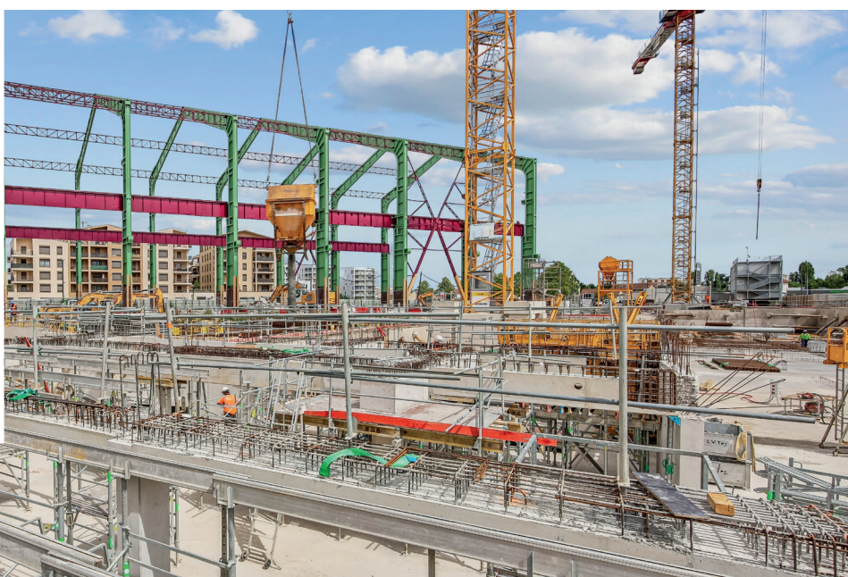
Journée de lancement des travaux de la Halle Sulzer
