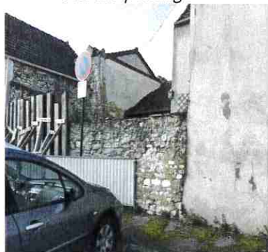
Mur sur parking
